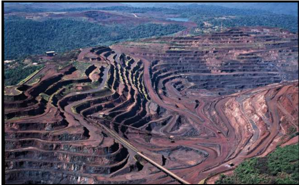
Figura 1- Lavra de minério de ferro pelo método a Céu Aberto Fonte: Geo902Ferro, 2012
