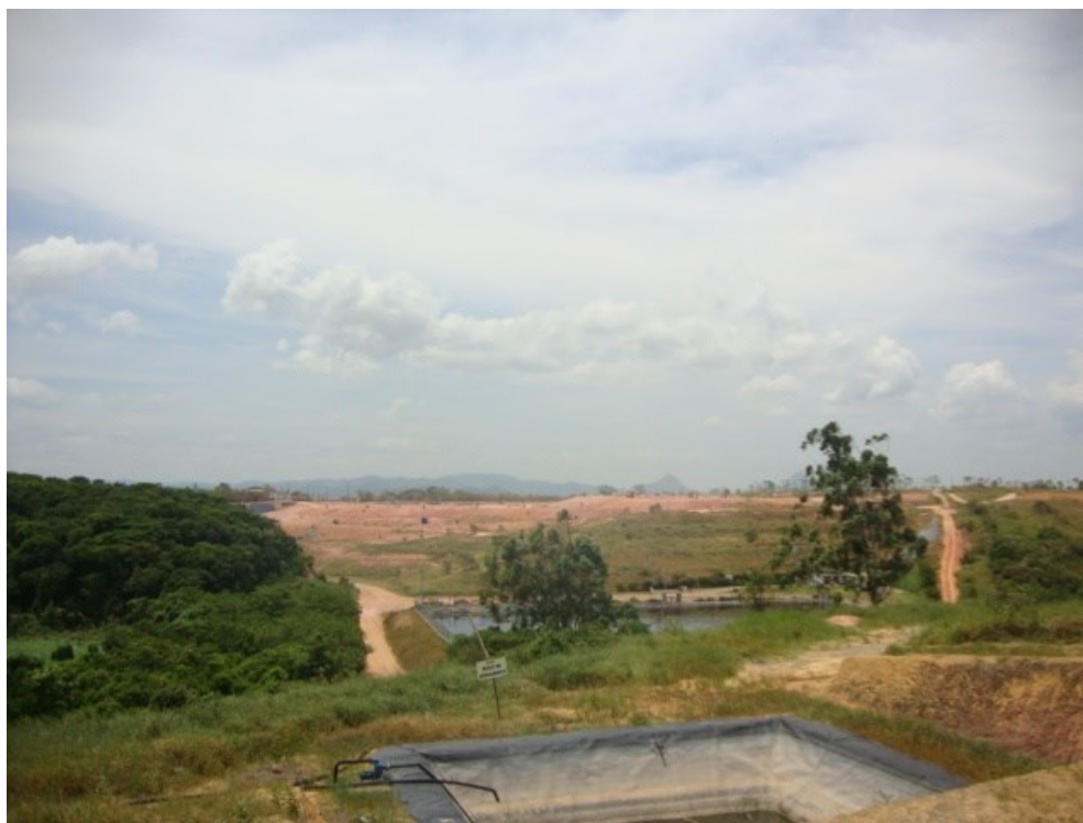
Vista parcial do aterro e do sistema de tratamento de chorume da Empresa CTRVV.
